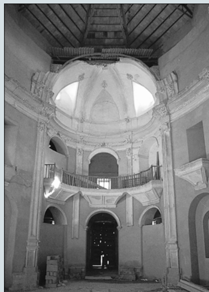
Rehabilitación de la Iglesia de los Trinitarios. Baeza (Jaén)
