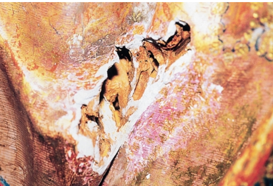
Orificios de salida insectos, produciendo graves pérdidas de soporte.
