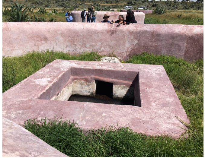
Acueducto del padre Tembleque, arquería mayor de Santiago de Tepeyahualco (1554-1571)
