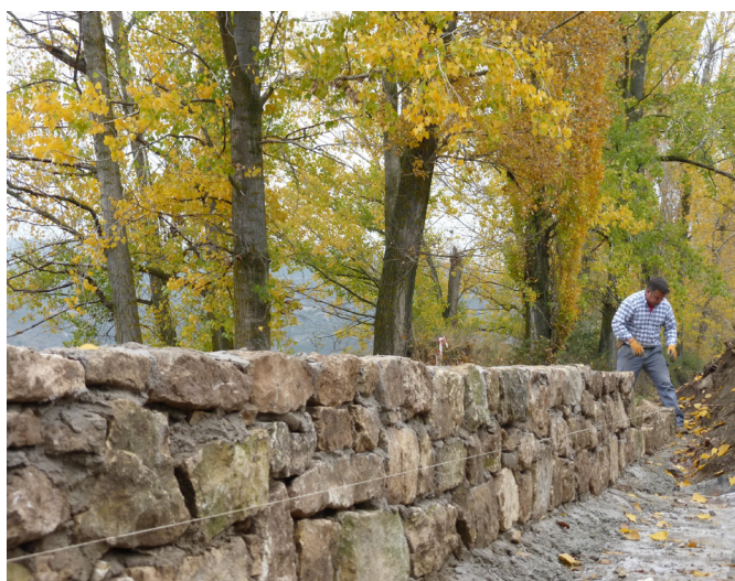
Muro de mampostería en construcción, reciclable y sin emisiones. Canal de Cabarrús, Madrid
