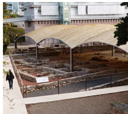
De izquierda a derecha: vista de la cubierta revestida de paneles de polivinilo; interior del conjunto de la Necrópolis; vista exterior de la ligera cubrición | fotos Calafellvala
