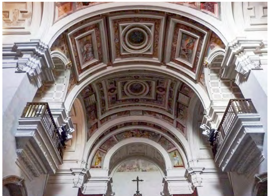
Imagen interior de la secuencia de bóvedas con la que se resuelven las techumbres de la capilla | foto Antonio Estepa Rubio
