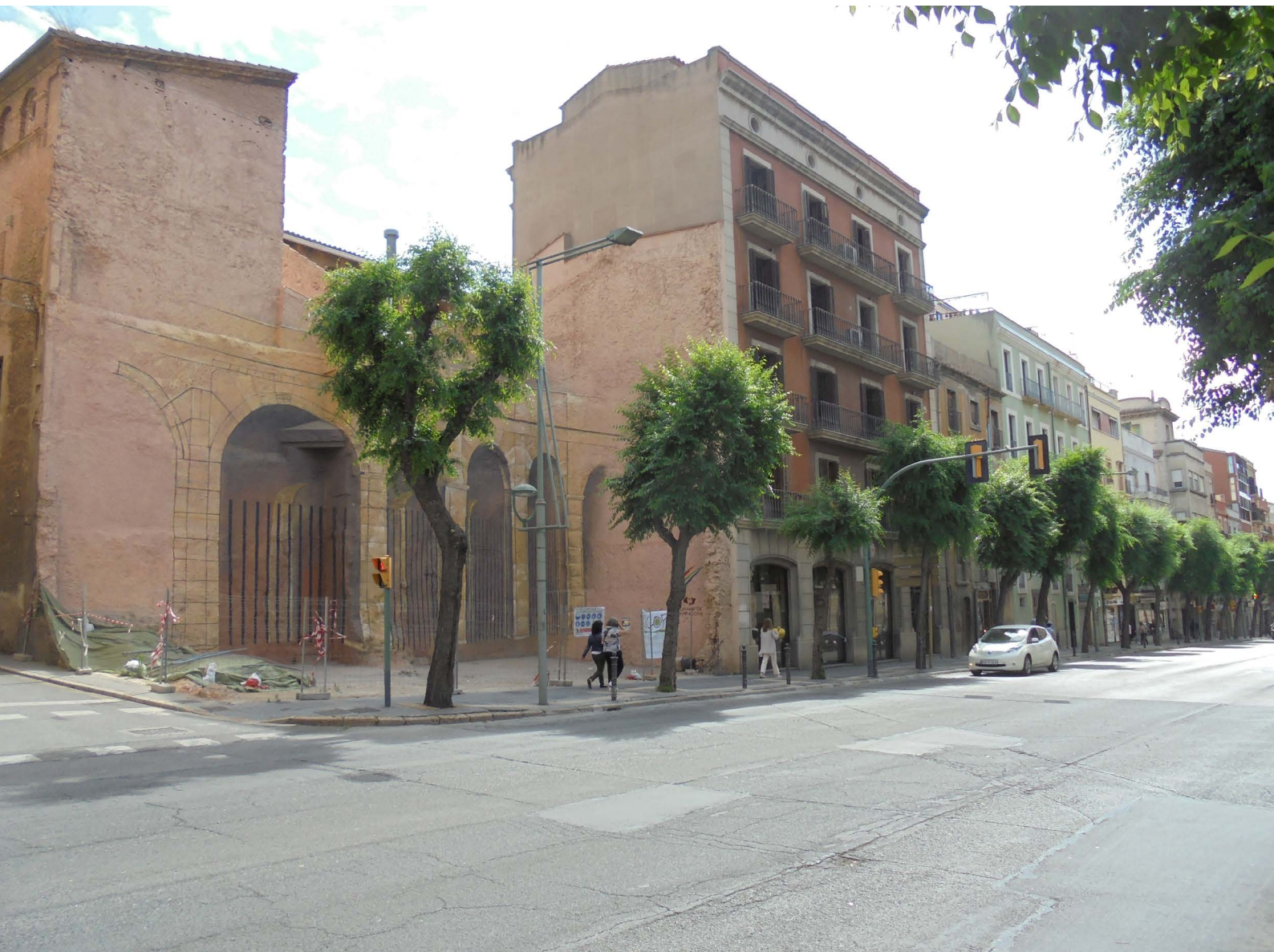
Proyecto Patrimoni de Façana que pretende recuperar y decorar fachadas/medianeras con trampantojos que expliquen las dimensiones de los monumentos de la ciudad. En el caso de Rambla Vella 55 se ha dibujado la fachada monumental del circo, como primera experiencia financiada por la Fundació Privada Mutua Catalana | foto J. Menchón, Ayuntamiento de Tarragona
