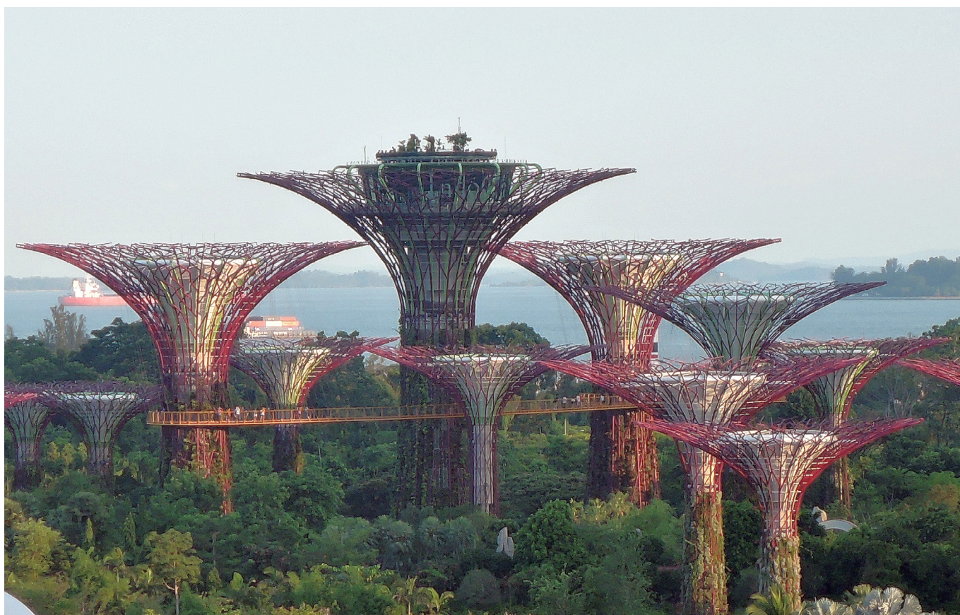
Gardens by the bay (Singapur), los llamados “súper árboles” artificiales que funcionan con paneles solares que se encargan de recolectar la energía suficiente para iluminarlos, y cuando llueve, un sistema recolecta el agua para regar los helechos y enredaderas que lo adornan | foto Güldem Üstün
