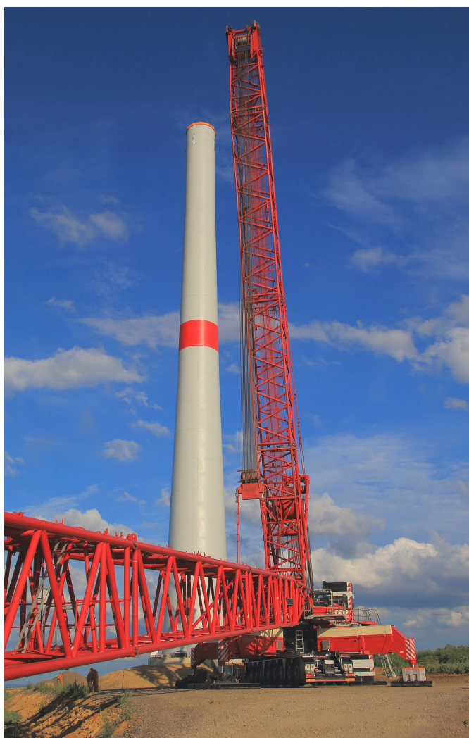
Torre de turbina eólica en construcción | foto pixabay
