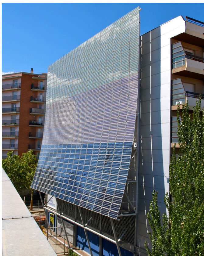
Fachada fotovoltaica en el edificio MNACTEC, Tarrasa | foto Chixoy
