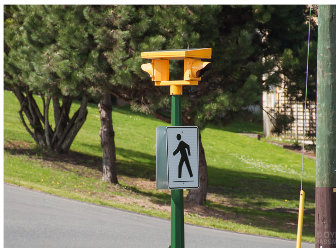
Señal de paso de cebra alimentada con energía solar. Victoria (Canadá) | foto Dylan Passmor
