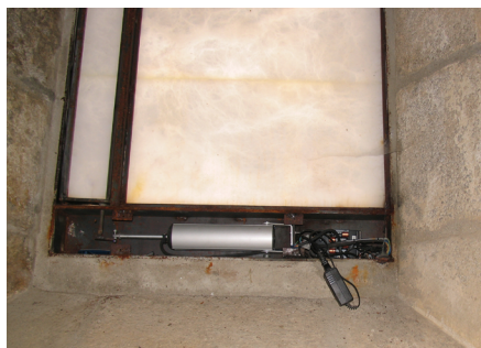
Detalle del mecanismo automático de control de apertura de la ventana. El mecanismo se oculta con una chapa de igual color que la carpintería logrando una integración completa
