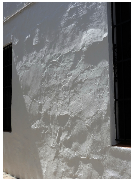
Revoco de cal en una fachada del centro histórico de Carmona (Sevilla): aporta la calidez y la textura de un revestimiento de cal aérea que contrasta muy positivamente con la mayoría de revocos de mortero de cemento pintados. Además de la sostenibilidad implícita del material, no está afectada por desprendimiento de pintura, con lo que la intervención acaba siendo más durable (sostenible en en sentido económico y funcional de la aplicación) | foto Fempatrimoni 2.0
