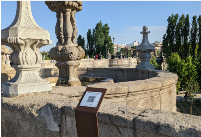
Báculos con códigos QR instalados en el puente de Toledo
