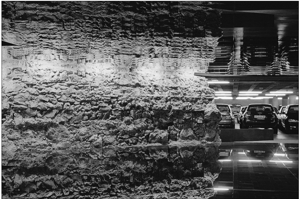
5. Integración de restos del muro portuario del aparcamiento
