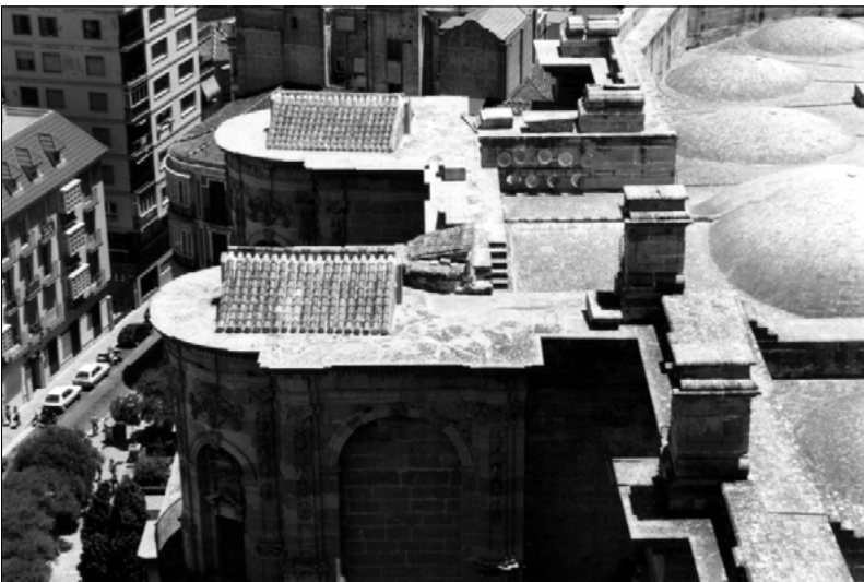
1. Cubiertas y pretilos de la nave Norte desde la central.
