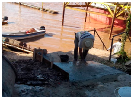
Obra y mejoramiento de la explanada y de la bajada | fotos Pablo Benve (Multisectorial por los Humedales)
