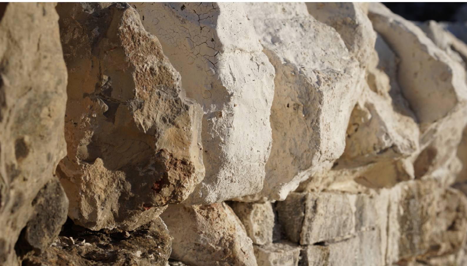
Detalle del muro de piedra en Atzeneta del Maestrat, que forma parte del proyecto Piedra, transmutación y vida en común de Ana Sánchez y Rafael Tormo (2024) | foto Marc Martínez
