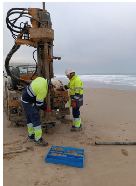
Sondeos geotécnicos en la playa de Camposoto (San Fernando, Cádiz)
