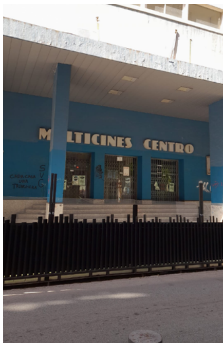
A la izquierda, antiguo cine Aliatar de Granada. Registrado sin protección (código 01180870243) | foto Aristoi
