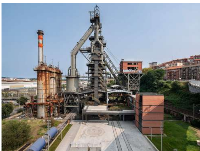
Horno Alto n.º 1 de AHV en Sestao (Bizkaia, 2024), tras la actuación de urbanización y accesibilidad (Garitano Arquitectos) y antes del comienzo de la última fase de restauración por el IPCE | foto José Manuel Cutillas
