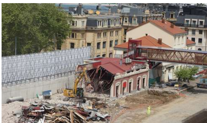
Estación histórica del Norte de San Sebastián, durante la demolición (2023) | foto Ancora
